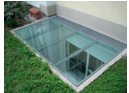
Abb. 3: Begehbare Betonlichtschacht mit Glasabdeckung – ideale Ergänzung des Kellers: funktional, formstabil, ästhetisch und nachhaltig [5]
